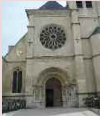
La restauration intérieure et extérieure de l'église (clocher, chauffage, mise en valeur d'œuvres d'art, parvis)
