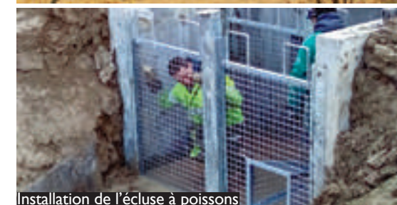
Installation de l'écluse à poissons
