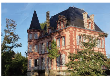
MAIRIE ANNEXE DU CASTELROSE LES SERVICES ADMINISTRATIFS
